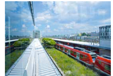
S-Bahnhof Donnersbergerbrücke – endlich barrierefrei
